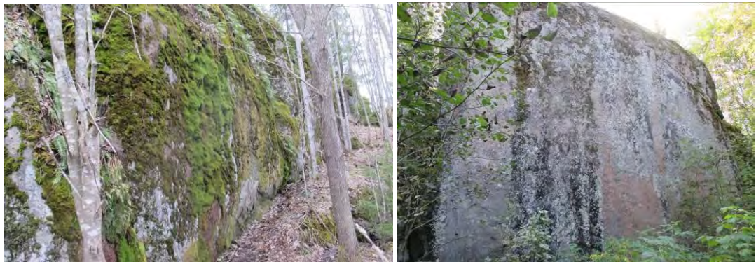
Kuvat 12 ja 13. Sikovuoren jyrkänteen matalampi eteläosa ja pystyseinämainen pohjoisosa.
